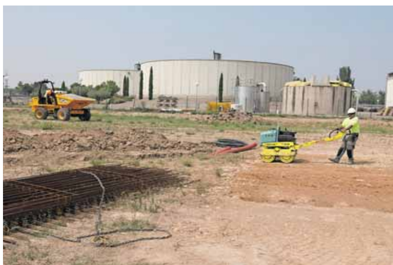
Imagen de los trabajos que se están llevando a cabo para mejorar la depuradora de aguas residuales.
